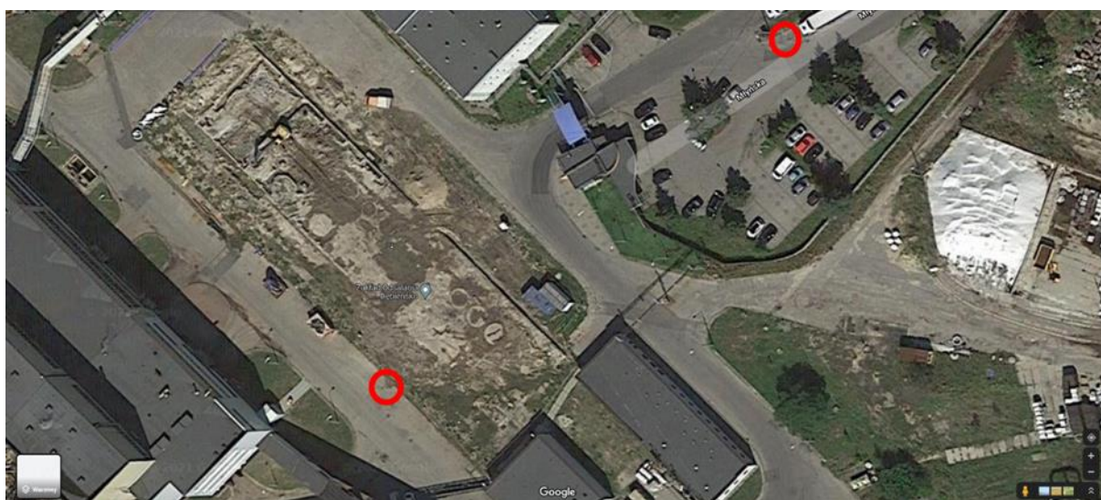
Załącznik 2 – Mapa sytuacyjna – Zakład Główny – zapadnięta studzienka kanalizacyjna – 2 sztuki 2 x 2 m. (Dział OP)
