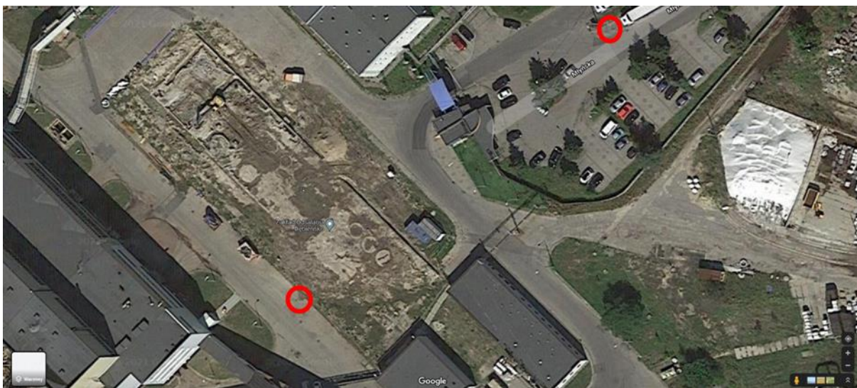
Załącznik 2 – Mapa sytuacyjna – Zakład Główny – zapadnięta studzienka kanalizacyjna – 2 sztuki 2 x 2 m. (Dział OP)
